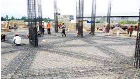
Gambar 3.9 : Pemadatan Tanah Setelah pengecoran rib-rib Sumber : ruangsipil.blogspot.com
