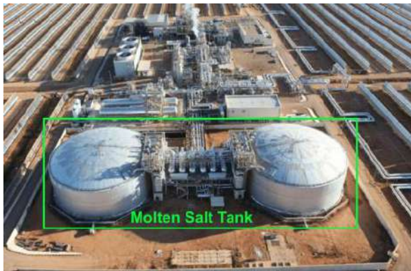
Gambar 2.12 Molten salt tank sebagai TES pada CSP farm [30]
