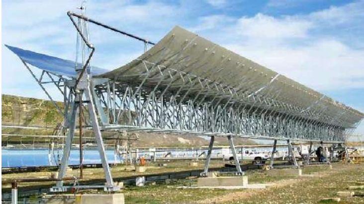
Gambar 4.5 Struktur baja dari desain collector EuroTrough-100 [45]
