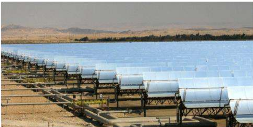
Gambar 4.13 Model susunan PTC secara paralel [47]
