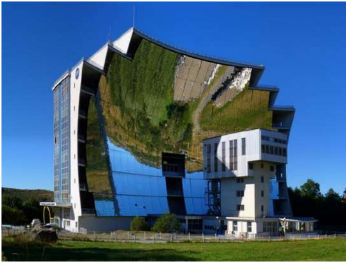
Gambar 5.2 Fasilitas solar furnace di Prancis kapasitas 1 MW [42]
