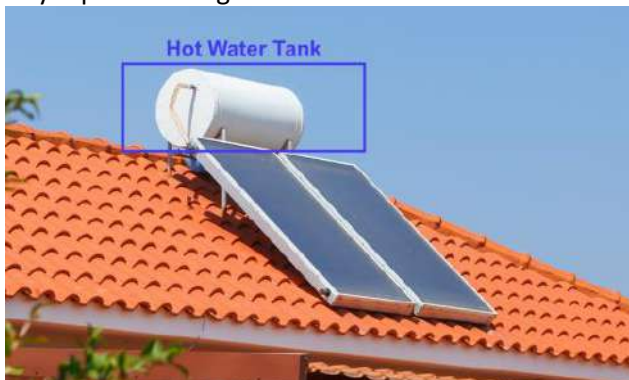
Gambar 2.11 Penyimpanan air panas pada solar water heater [29]
