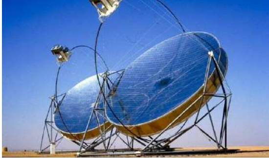
Gambar 6.5 Model concentrator dengan metal membrane berukuran 17 m [55] dan [56]
